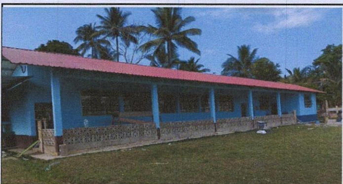
Foto 3: barandas con celocia de concreto.
